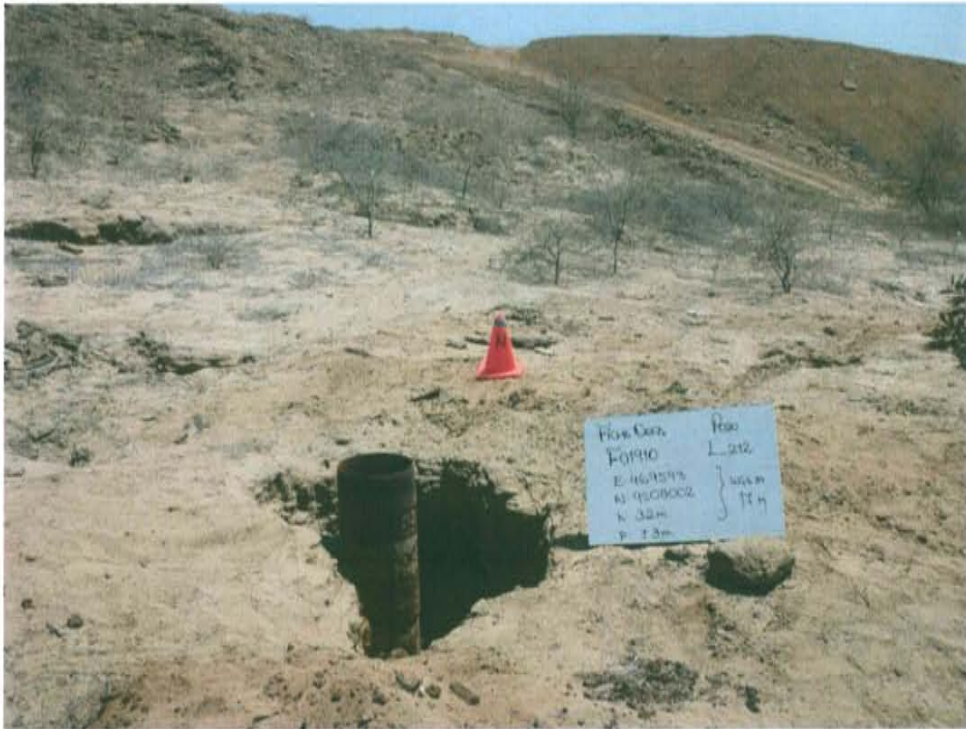
Fotografía N° 1. Identificación del pozo inactivo con código PERUPETRO L_212. Presenta casing abierto al medio ambiente.
