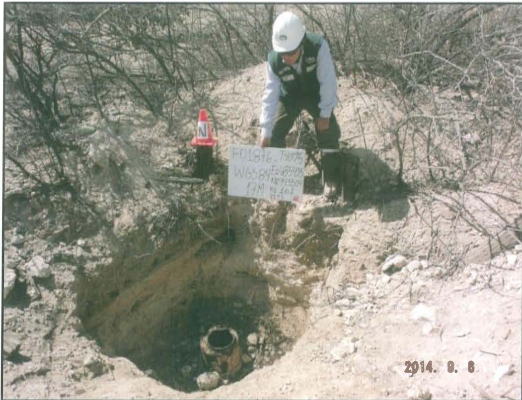
Fotografía N° 1. Pozo inactivo que se encuentra dentro de hoyo, se observa casing cortado y abierto al ambiente.
