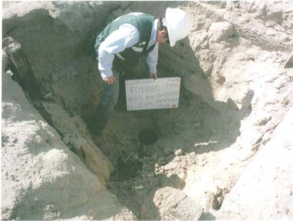
Fotografía N° 1. Pozo inactivo que se encuentra dentro de cantina deteriorada, se observa casing a nivel del suelo.
