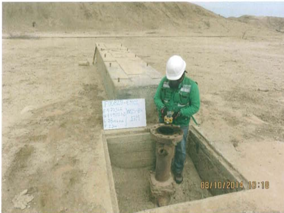
Fotografía N° 6. Medición en el punto F00828-EM01, ubicado en la boca del pozo.
