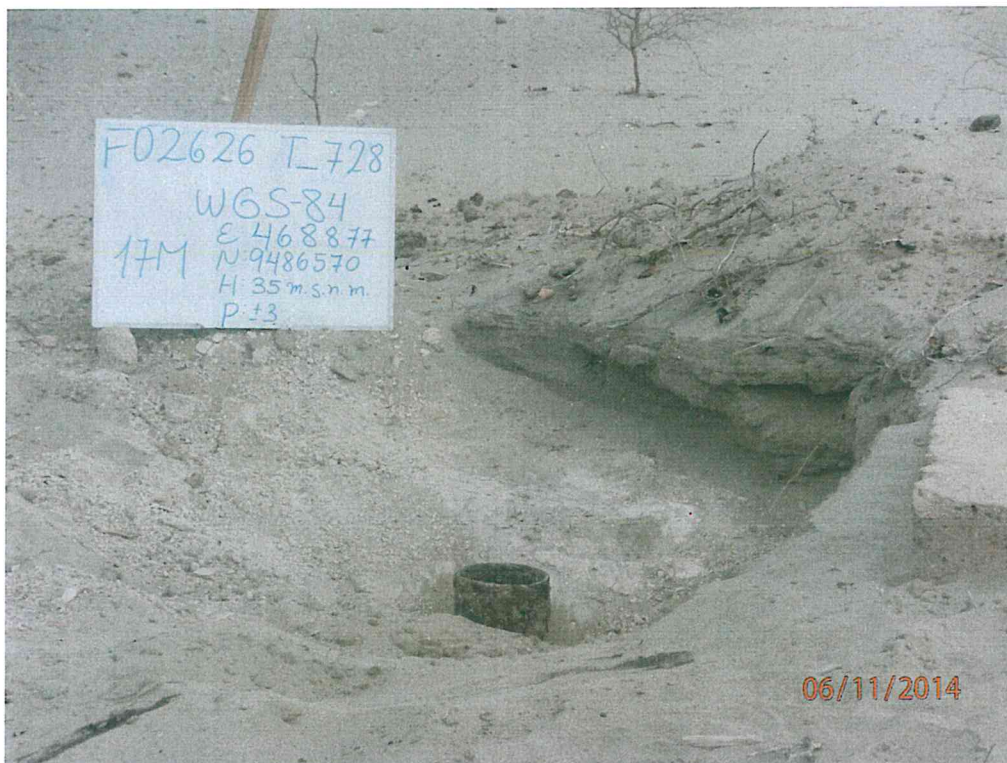
Fotografía N° 1. Pozo inactivo, se observa el casing en estado avanzado de corrosión y se encuentra expuesto al ambiente
