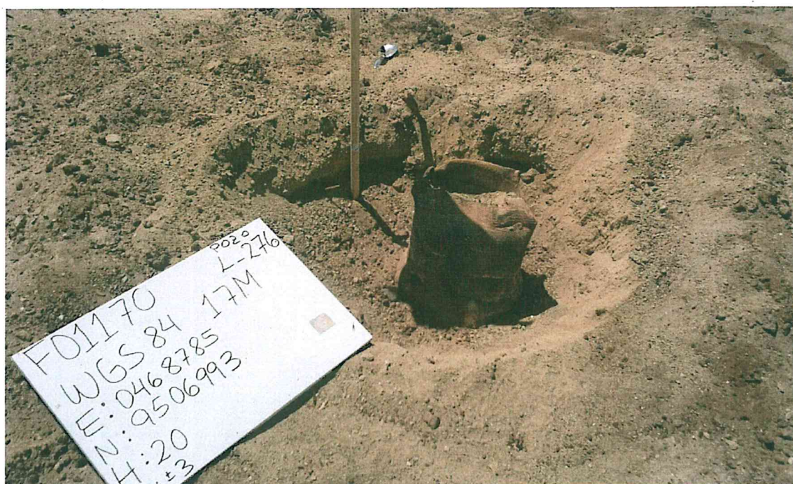
Fotografía N° 1. Identificación del pozo inactivo con código PERUPETRO L_276. Presenta casing corroído y deteriorado en el interior de una excavación, sin elementos de cierre que aseguren el hermetismo del pozo.
