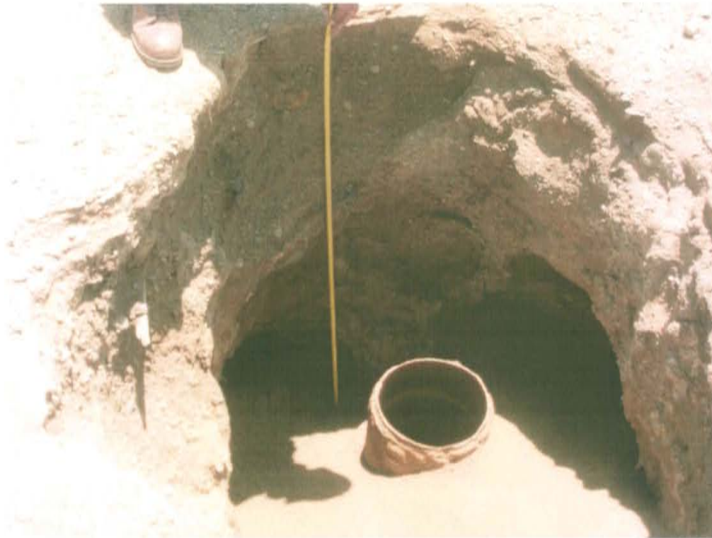
Fotografía N° 1. Identificación del pozo inactivo con código PERUPETRO T1748. Presenta casing abierto al medio ambiente.
