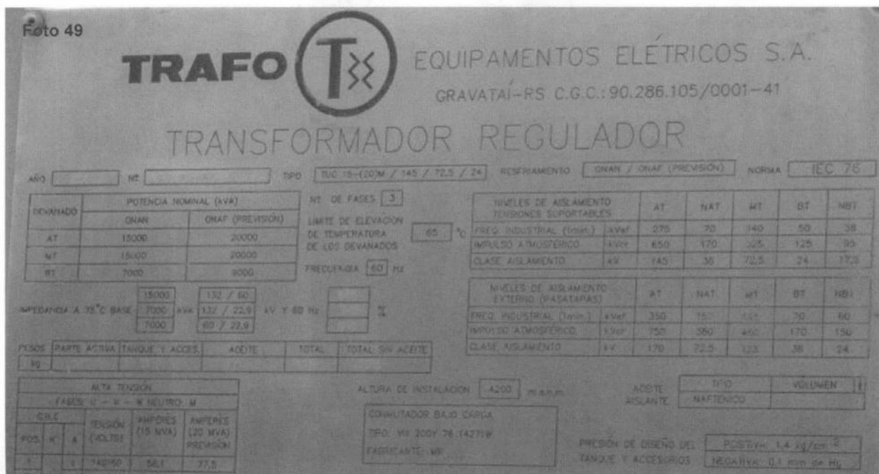
Fotografía N° 48. Evaluación de la placa del transformador eléctrico de Serie N° A0982A001 (Datos de Potencia, Peso y tipo de aceite, año de fabricación y peso bruto del equipo), en el en la Subestación de Cachimayo, de la empresa EGEMSA, en el punto georeferenciado N° 1, del Cuadro N° 3. Coordenadas UTM WGS 84 (18L 817 100E 8508507N )
