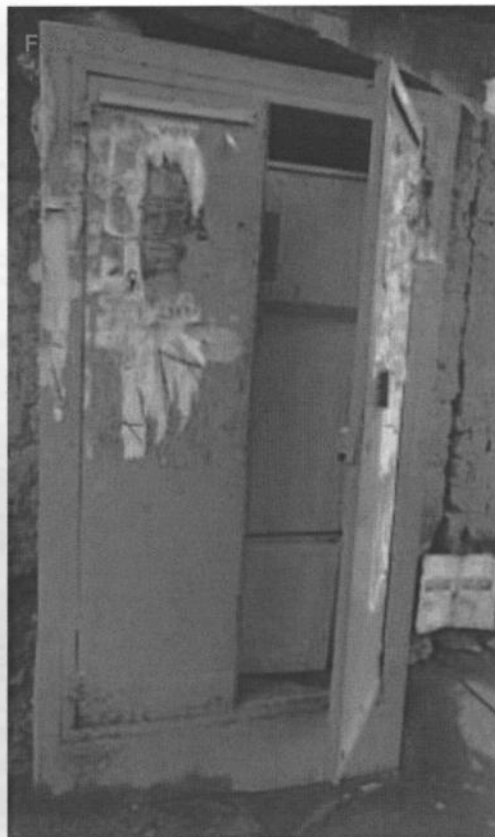
Fotografías N° 97a y 97b. Evidencias de la evaluación del uso adecuado de aceites dieléctricos en transformadores de distribución en servicio, ubicados en la vía Pública del distrito de San Sebastián; en el punto georeferenciado N° 32, del Cuadro N° 5. El transformador se encuentra con la puerta abierta, la chapa malograda y cerca existen varios niños. Coordenadas UTM WGS 84 (19L 183810E 8502197N)
