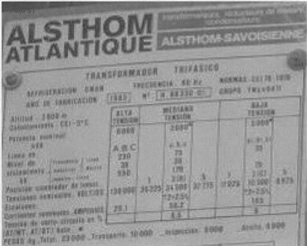
Fotografía N° 51. Evaluación de la placa del transformador eléctrico de Serie N° A0982A001 (Datos de Potencia, Peso y tipo de aceite, año de fabricación y peso bruto del equipo), en el en la Subestación de Cachimayo, de la empresa EGEMSA, en el punto georeferenciado N° 1, del Cuadro N° 3. Coordenadas UTM WGS 84 (18L 817100E 8508507N)
