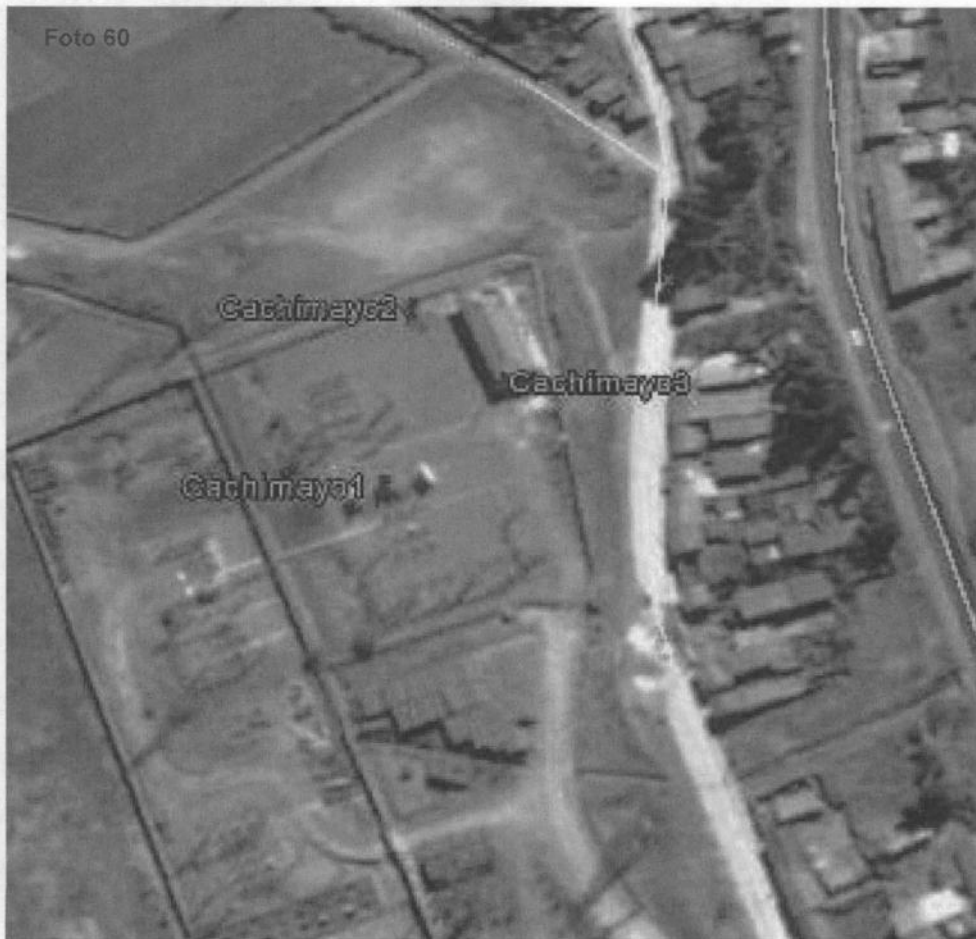
Fotografía N° 60. Imagen satelital de la distribución de los puntos identificados y evaluados en la Subestación de Cachimayo de la empresa EGEMSA, en el grupo de puntos georeferenciados N° 3, del Cuadro N° 3. Coordenadas UTM WGS 84 (18L 817100E 8508507N, 18L 817106E 8508556N y 18L 817126E 8508534N)
