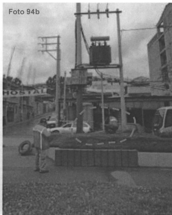
Fotografías N° 94a y 94b. Evidencias de la fuga de aceite dieléctrico en el transformador de distribución en servicio ubicados en la vía Pública del distrito de San Sebastián; en el punto georeferenciado N° 30, del Cuadro N° 5. Coordenadas UTM WGS 84 (19L 182659E 8502301N)
