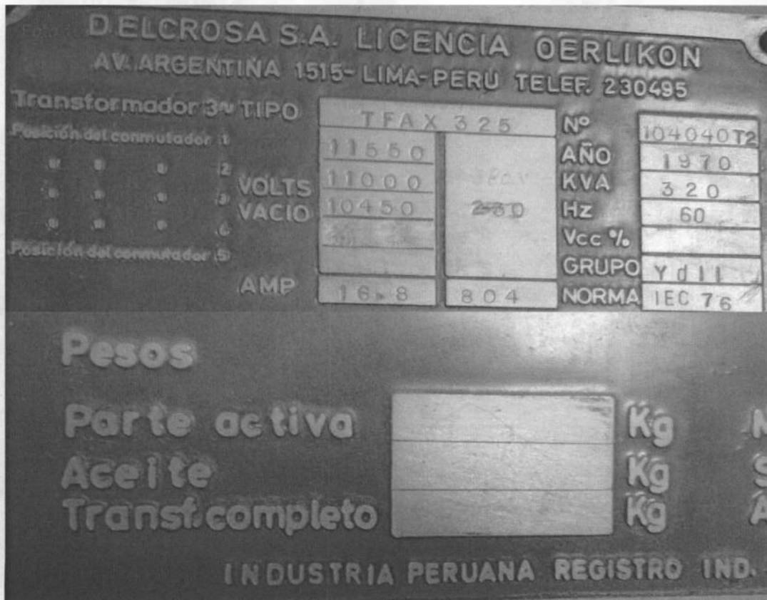
Fotografía N° 19. Evaluación de la placa del transformador eléctrico de Serie N° 104040T2 (Datos de Potencia, Peso y tipo de aceite, año de fabricación y peso bruto del equipo), en el taller de mantenimiento general de la Central Térmica de Dolorespata de la empresa EGEMSA, en el punto georeferenciado N° 1, del Cuadro N° 2. Coordenadas UTM WGS 84 (19L 178374E 8501976N)
