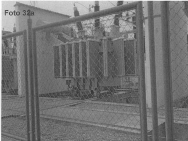
Fotografías N° 32a y 32b. Vistas panorámica de los transformadores de transmisión de potencia operativos Grupo 1 y Grupo 2, en el patio de llaves de la Subestación de Dolorespata de la empresa EGEMSA, en el punto georeferenciado N° 5, del Cuadro N° 2. Coordenadas UTM WGS 84 (19L 178330E 8502264N)
