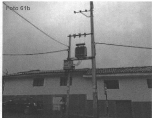
Fotografías N° 61a y 61b. Evidencias de la evaluación del uso adecuado de aceites dieléctricos en transformadores de distribución en servicio, ubicados en la vía Pública del distrito del Cusco; en el punto georeferenciado N° 1 del Cuadro N° 5. Coordenadas UTM WGS 84 (19L 176509E 8504408N)
