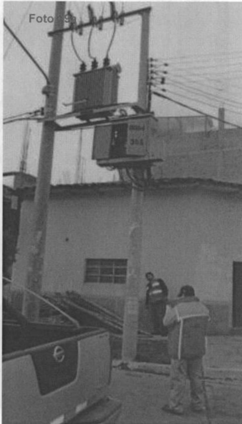
Fotografías N° 99a y 99b. Evidencias de la evaluación del uso adecuado de aceites dieléctricos en transformadores de distribución en servicio, ubicados en la vía Pública del distrito de San Jerónimo; en el punto georeferenciado N° 34, del Cuadro N° 5. Coordenadas UTM WGS 84 (19L 187177E 8500814N)
