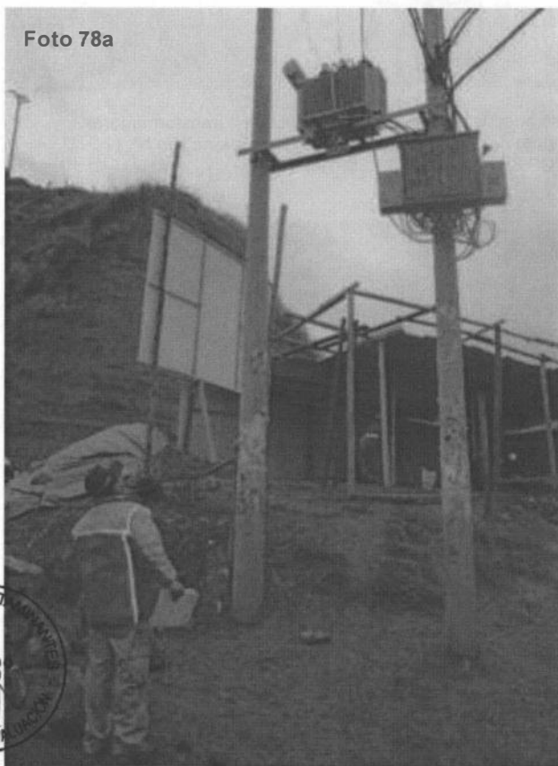
Fotografías N° 78a y 78b. Evidencias de la evaluación del uso adecuado de aceites dieléctricos en transformadores de distribución en servicio, ubicados en la vía Pública del distrito de Santiago; en el punto georeferenciado N° 16, del Cuadro N° 5. Coordenadas UTM WGS 84 (19L 177163E 8500660N)
