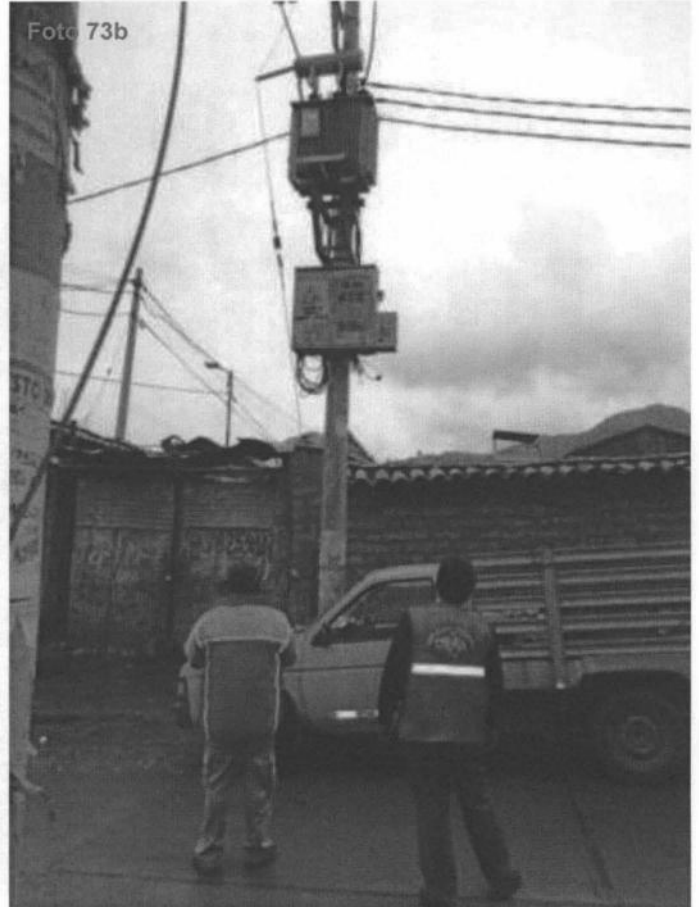
Fotografías N° 73a y 73b. Evidencias de la evaluación del uso adecuado de aceites dieléctricos en transformadores de distribución en servicio, ubicados en la vía Pública del distrito de Santiago; en el punto georeferenciado N° 12, del Cuadro N° 5. Coordenadas UTM WGS 84 (19L 176692E 8502902N)
