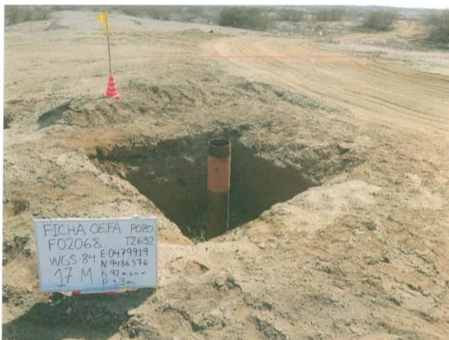
Fotografía N° 1. Pozo inactivo ubicado en una cantina deteriorada, con casing expuesto al ambiente.
