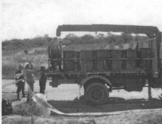
Fotografía 7-a. Cilindros conteniendo agua con petróleo extraídos del estancamiento.
