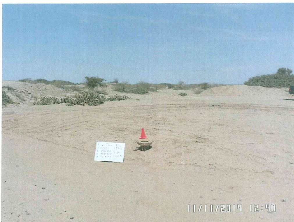
Fotografía N° 1. Vista pozo T3773 ubicado en una planicie, se observa el casing abierto al ambiente.
