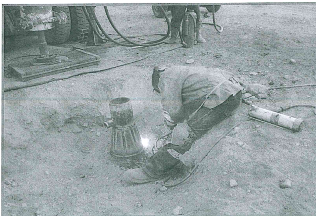
Foto 2: Acondicionamiento de boca de pozo con campana reductora.
