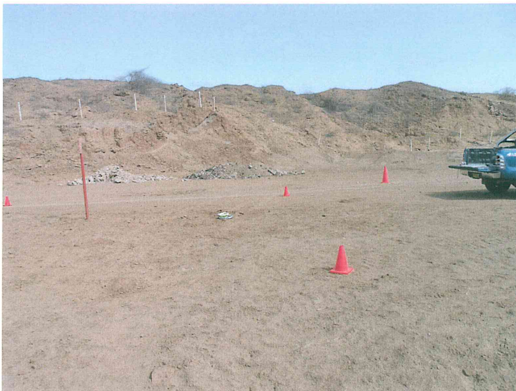
Fotografía N° 3. Vista de la ubicación del pozo abandonado permanentemente al pie de un monte sobre un terraplén y al lado de la vía afirmada que comunica con un pozo activo.
