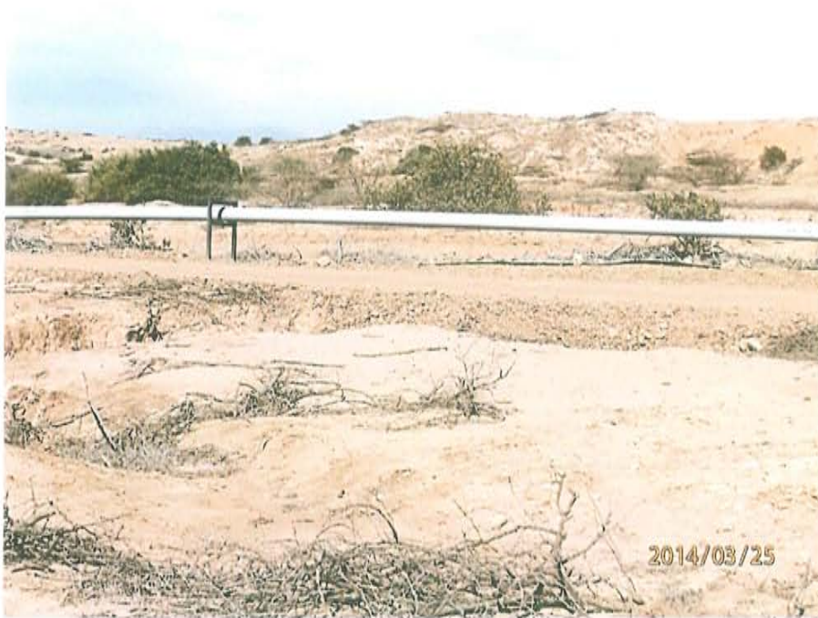
Fotografía N° 3. A 15 m del pozo T_673 se observa una tubería industrial junto a una trocha afirmada.
