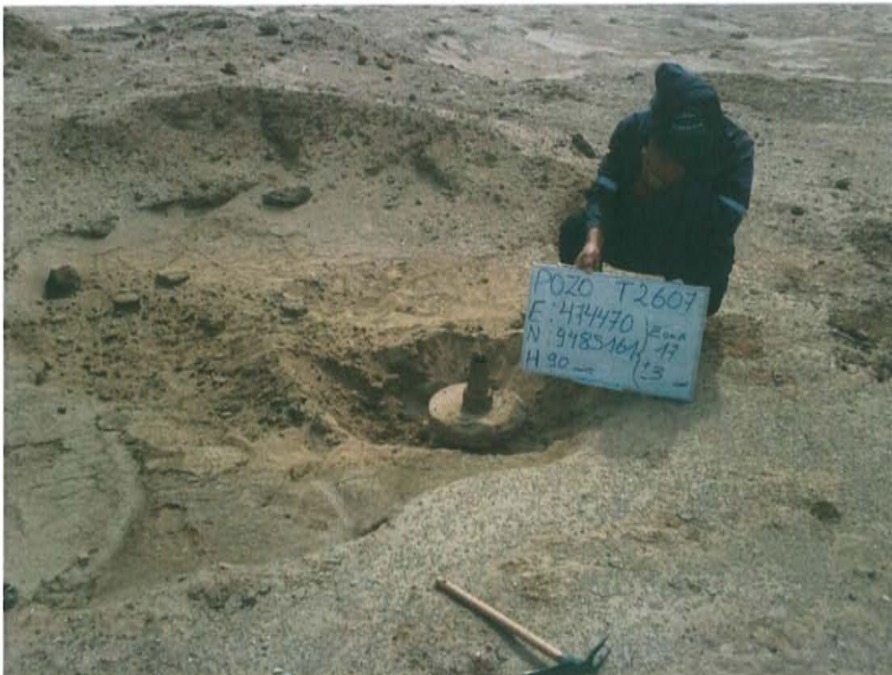
Fotografía N° 1. Pozo con código PETRUPETRO T2607 inactivo mal abandonado en el cual se observa el casing con brida.
