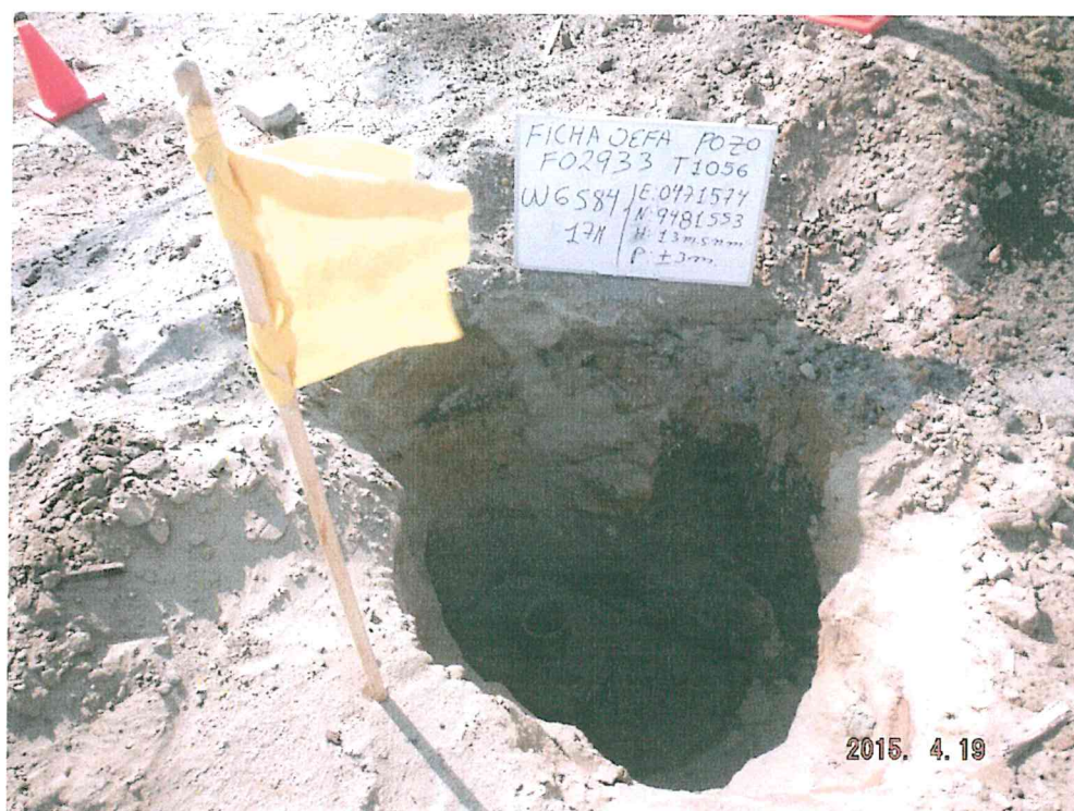
Fotografía N° 2. Se aprecia que el pozo T1056 no presenta elementos que garanticen el cierre hermético del pozo, el pozo presenta brida reductora de 5 pulgadas de diámetro.
