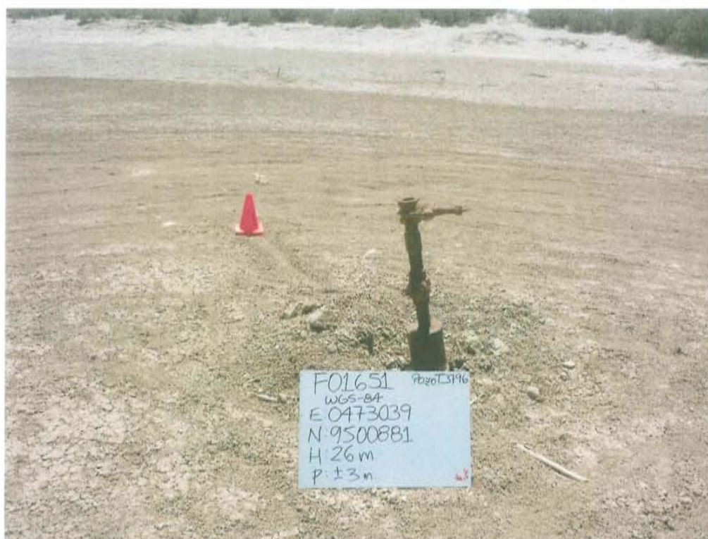
Fotografía N° 1. Pozo inactivo de la ficha F01651 que muestra casing de superficie a 0,85 m sobre el nivel del suelo, corroído y con válvula pero que debido a su estado de corrosión no se aseguraría su hermetismo.
