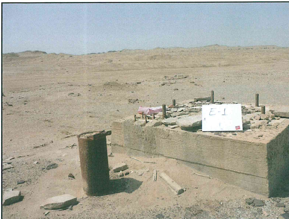
Fotografía N° 1. Vista de la instalación de producción inactiva mal abandonada, correspondiente a la ficha OEFA F00391, no se observa suelo con presencia de Hidrocarburos ni afloramiento de fluidos.
