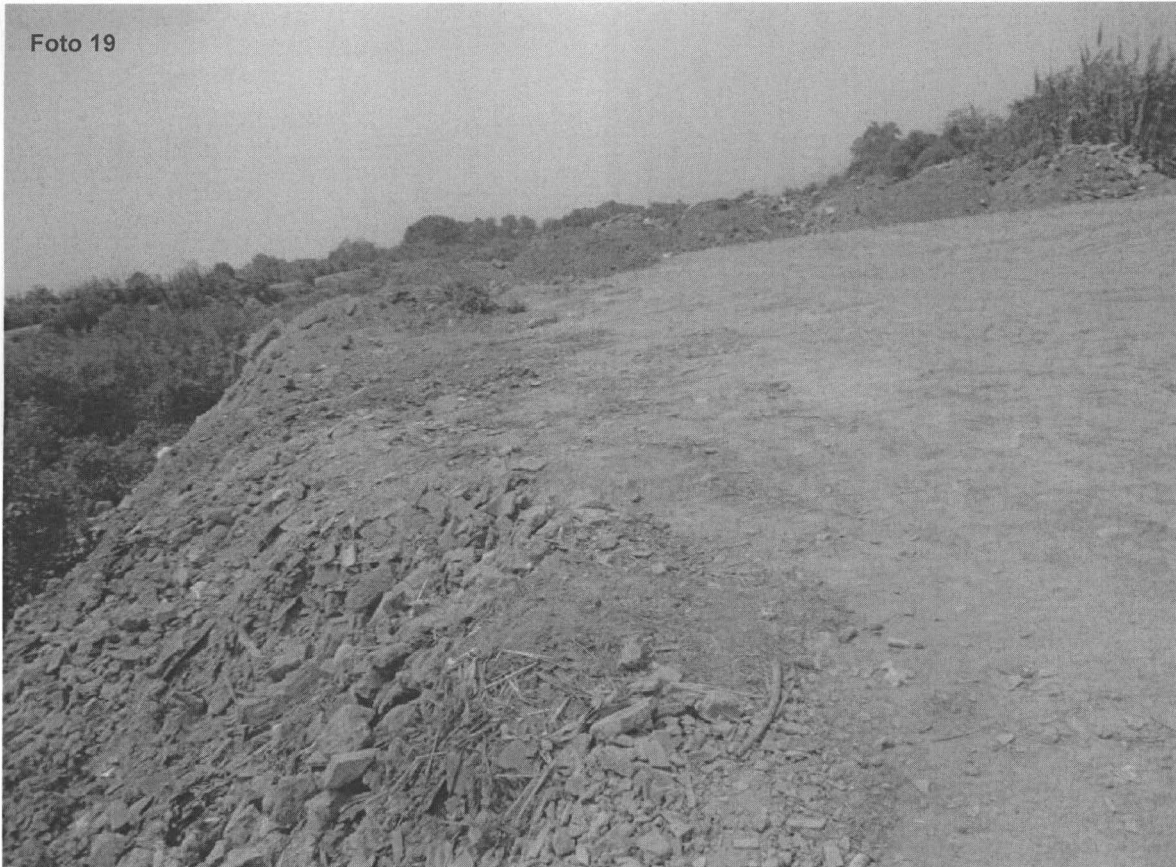
Fotografía N° 19. Evidencia de la magnitud de acumulación de residuos sólidos de construcción e industriales sobre el cauce del río Chillón, en el Punto georeferenciado N° 2, del Cuadro N° 4. Coordenadas UTM WGS 84 (18L 0276044E 8684539N)
