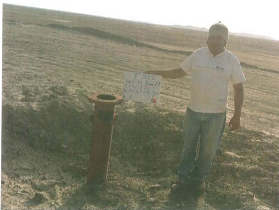
Fotografía N° 1. Ubicación del pozo inactivo en un terreno llano, expuesto al medio ambiente y en estado de corrosión que no cuenta con elementos de cierre en superficie no garantizando el cierre hermético del pozo.
