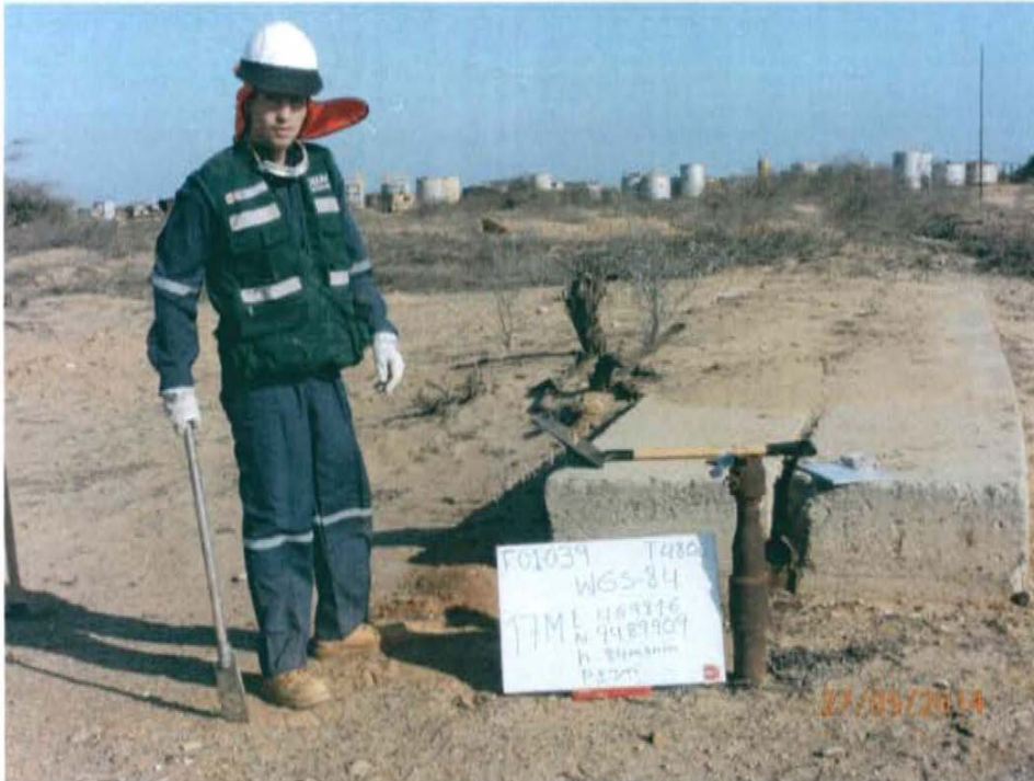
Fotografía N° 3. Se observa un monolito de concreto, ubicado a 0,7 m paralelo a la tubería de reducción del pozo T4806.
