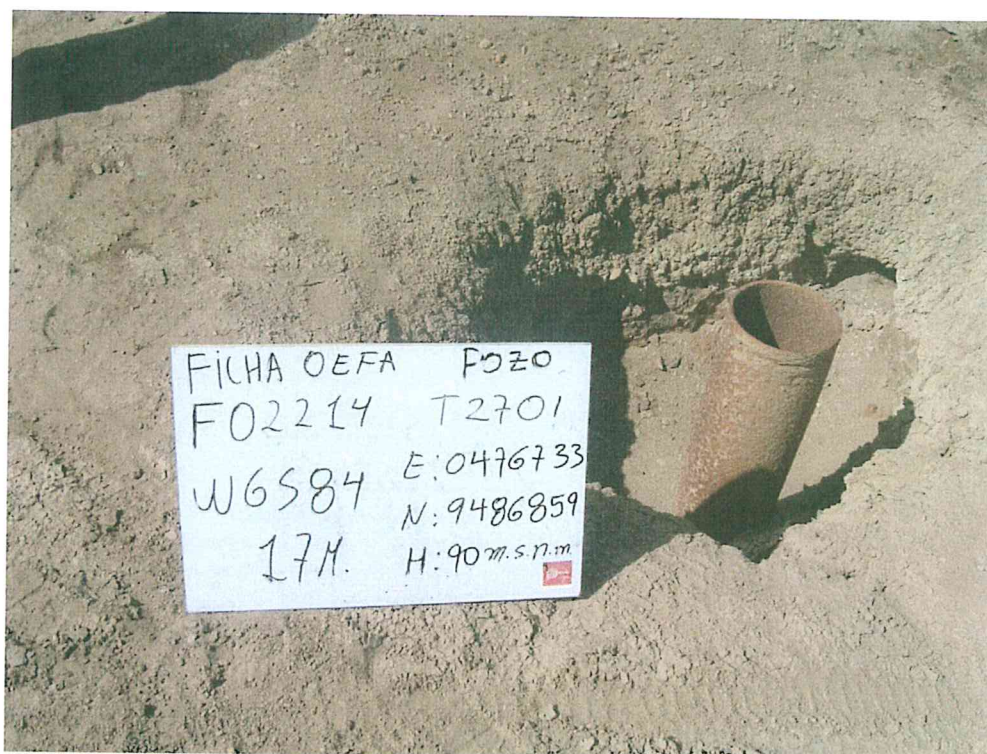
Fotografía N° 1. Se observa el casing del Pozo T2701, abierto y expuesto al ambiente sin ningún elemento de cierre, que asegure su hermetismo.
