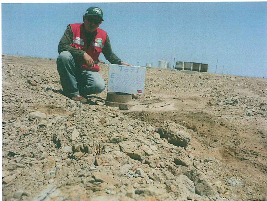
Fotografía N° 1. Pozo inactivo con código T_671, con casing que sobresale aproximadamente 0,2 m del nivel de superficie, presenta emisiones gaseosas.
