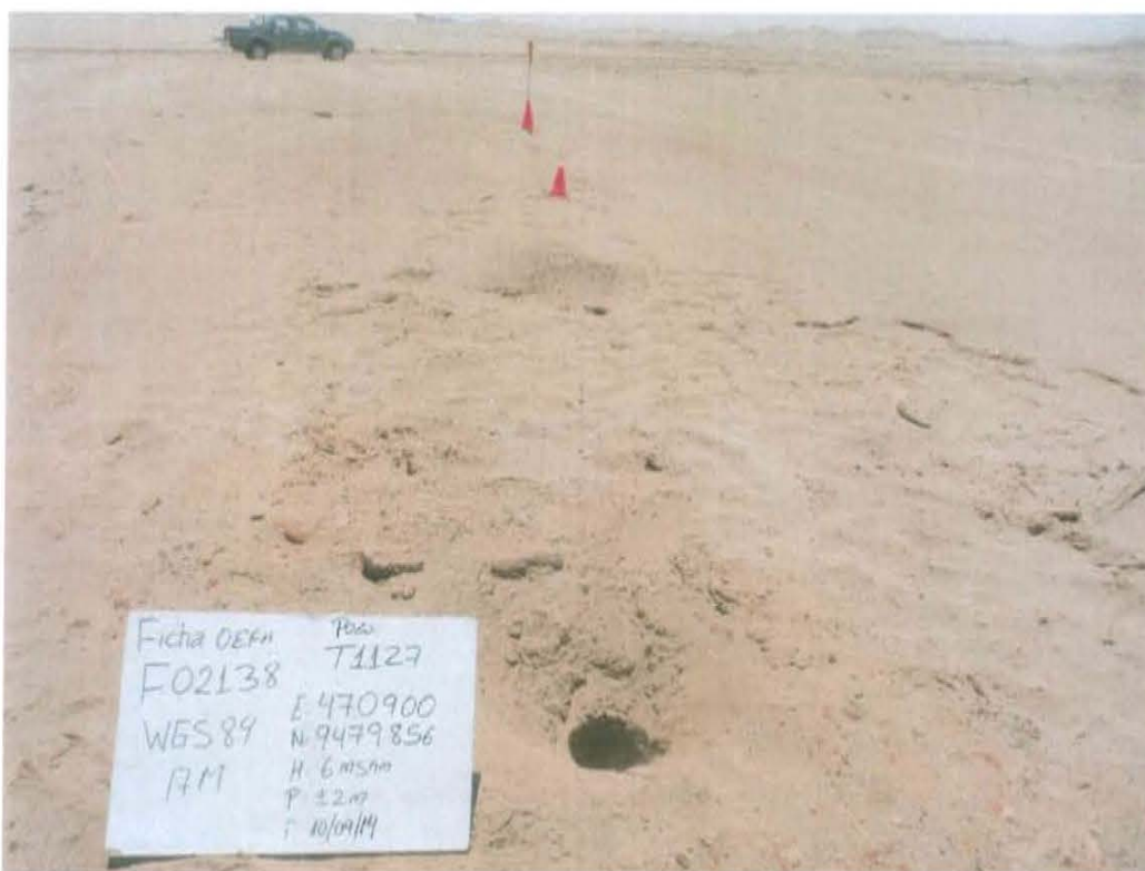
Fotografía N° 1. Se observa casing de 8 plg de diámetro a nivel de la superficie del suelo, por lo que se considera un pozo abierto al ambiente.
