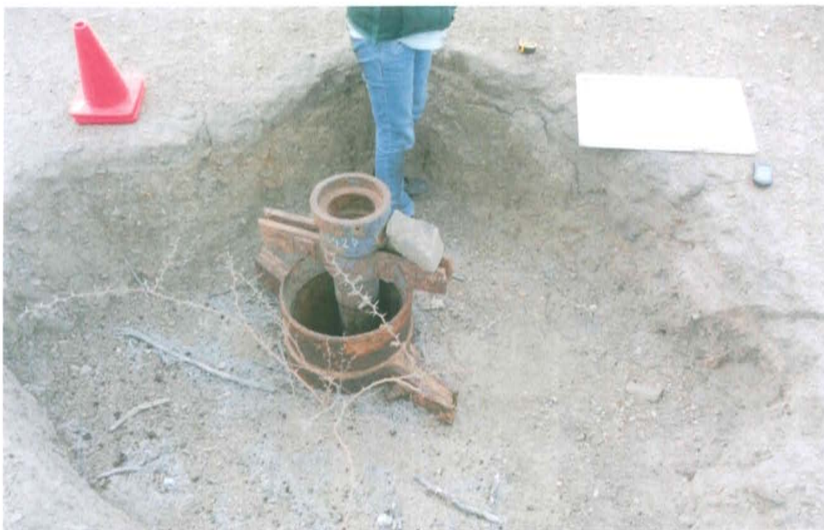
Fotografía N° 1. Pozo con código PERUPETRO T2063 y código Ficha OEFA F01236, se observa el casing del pozo y una tubería corroídos que no presenta cabezal y/o algún accesorio de cierre por lo que se encuentra abierto al ambiente.
