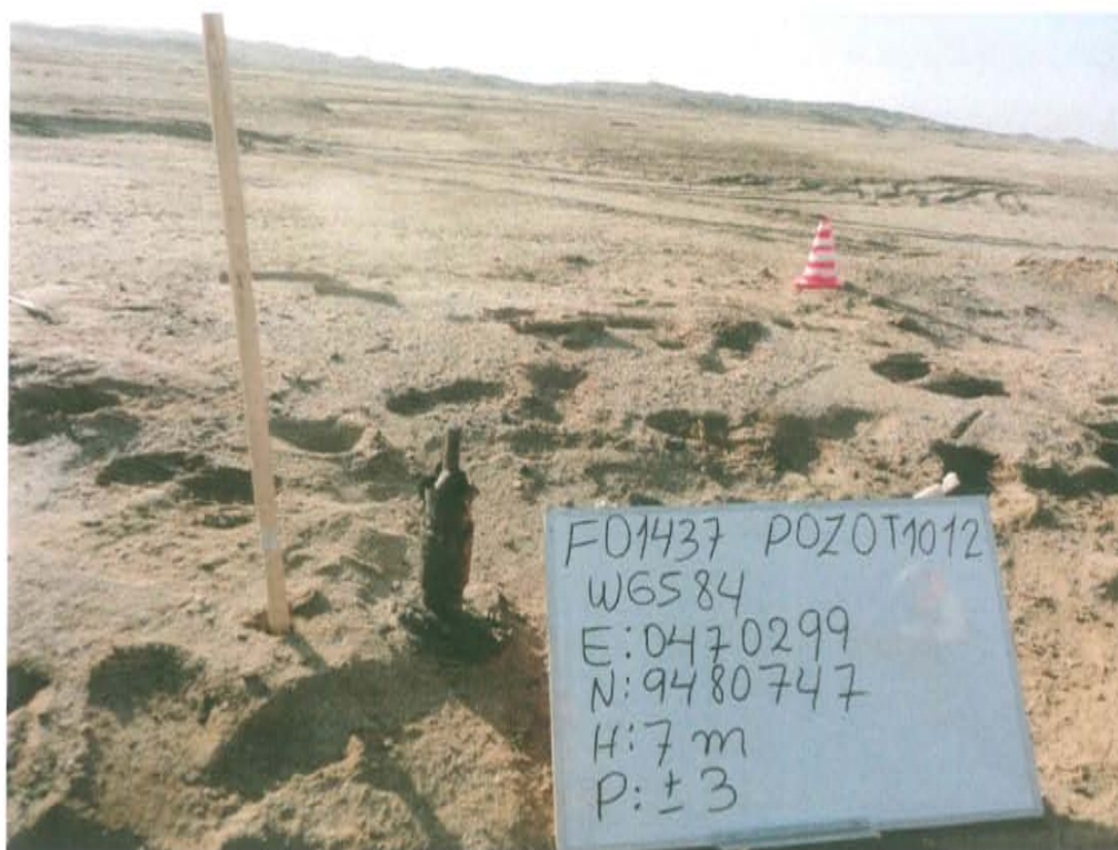
Fotografía N° 1. Identificación del pozo inactivo con código PERUPETRO T1012. Presenta casing abierto al ambiente.
