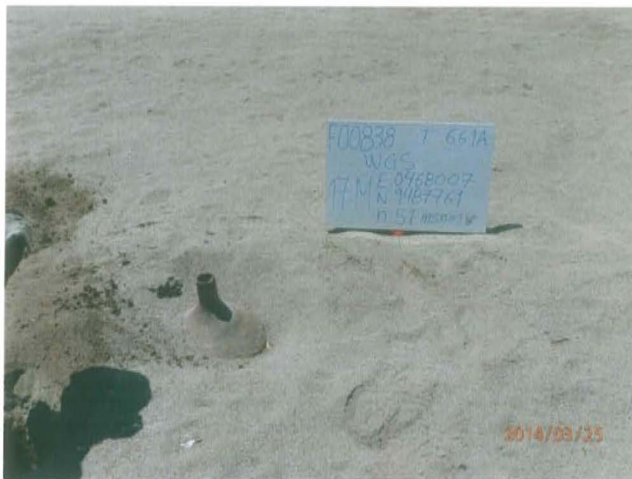
Fotografía N° 1. Pozo inactivo que presenta una tuberla de reducción.
