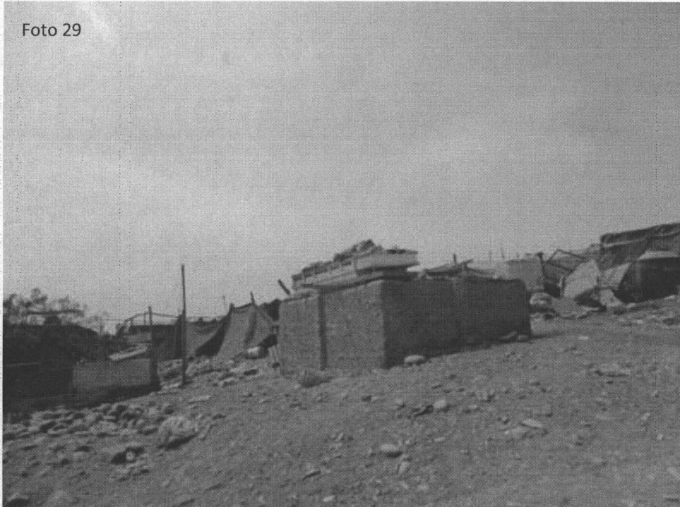
Fotografía N° 29. Evidencia de terrenos destinados al acopio y reciclaje informal de residuos sólidos, en el punto georeferenciado N° 4, del Cuadro N° 3. Coordenadas UTM WGS 84 (18L 0286143E 8647768N)
