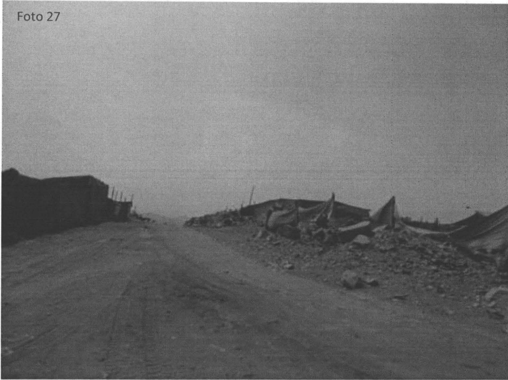
Fotografía N° 27. Evidencia de grandes lotes de terrenos que se dedican al acopio y reciclaje informal de residuos sólidos, en el punto georeferenciado N° 2, del Cuadro N° 3. Coordenadas UTM WGS 84 (18L 0285960E 8647872N)
