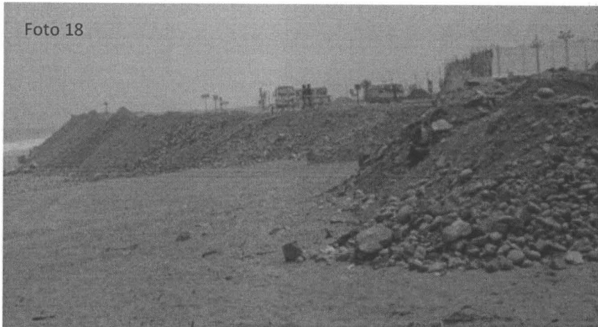
Fotografía N° 18. Evidencia de la magnitud del botadero de residuos sólidos de construcción, ubicado en la playa, en el punto georeferenciado N° 3, del Cuadro N° 2. Coordenadas UTM WGS 84 (18L 0286931E 8646325N)
