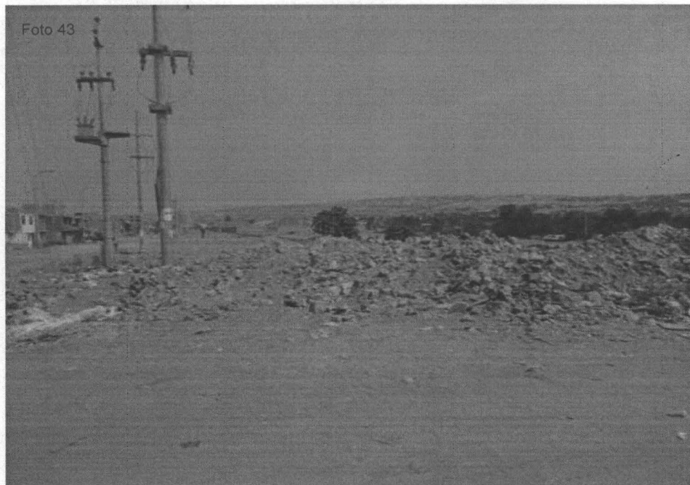
Fotografía N°43. Evidencia del arrojo de residuos de construcción en los alrededores de la Av. Juan Velasco Alvarado a 180 metros del cruce con la Av. Magisterio, en el sentido de Oeste a Este, en el Distrito de Villa El Salvador, en el punto georeferenciado N° 1, del Cuadro N° 4. Coordenadas UTM WGS 84 (18L 0287152E 8648545N)
