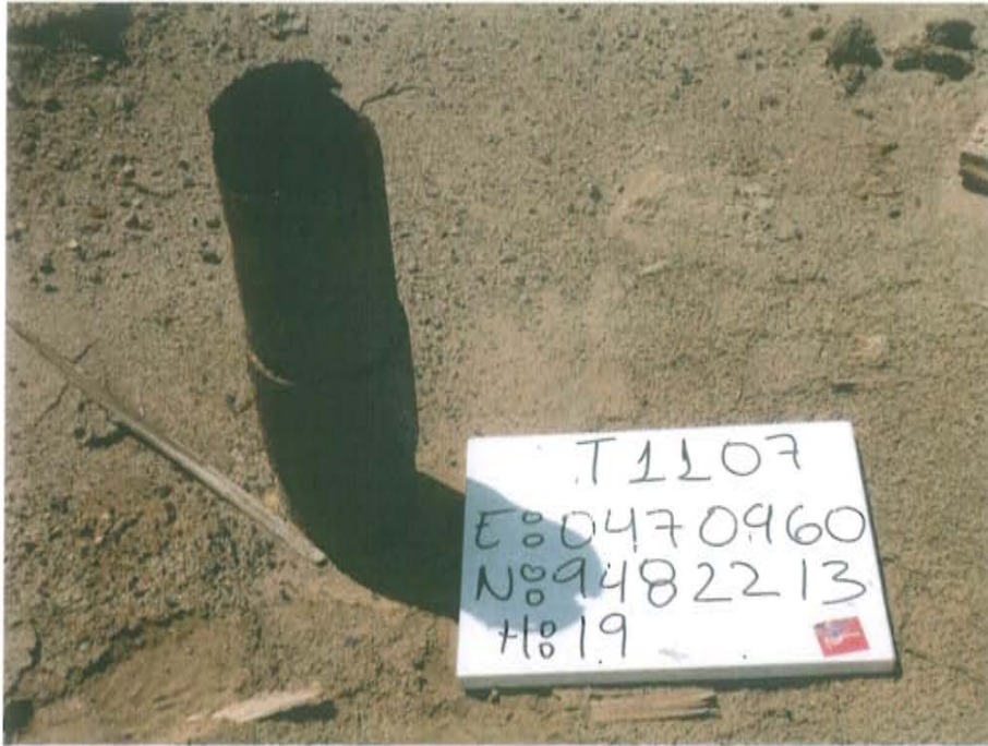
Fotografía N° 1. Pozo T1107, sin cabezal con tubo que emerge 0,42 m y abierto al ambiente.
