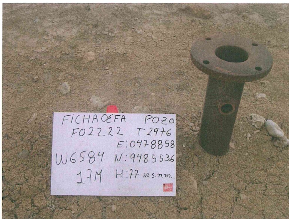
Fotografía N° 1. Se observa el Pozo T2976 el cual se encuentra abierto y expuesto al ambiente.
