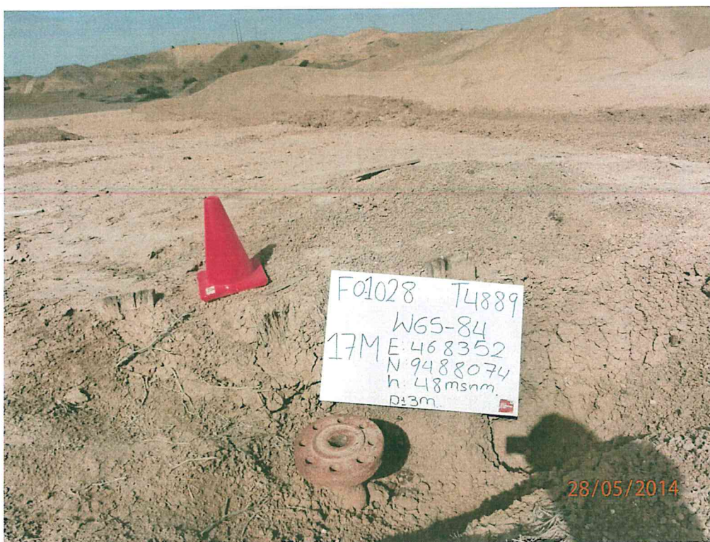
Fotografía N° 1. Pozo inactivo sin válvula que asegure su hermetismo, por lo que se encuentra abierta y expuesta la ambiente.
