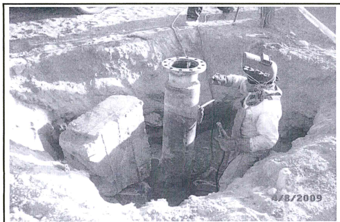
Foto 2. Excavó cantina encontró forros cortados de 10 3/4" OD, acondicionó y soldó encima extensión con brida en tope.
