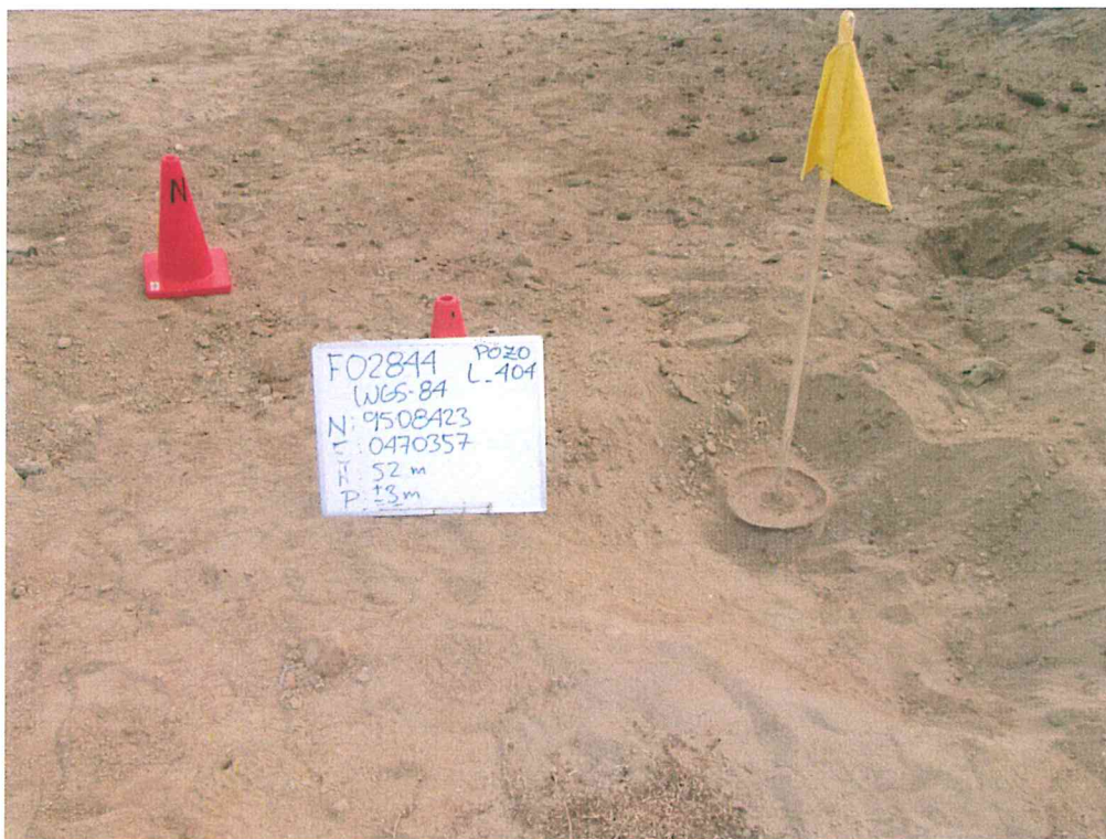
Fotografía N° 1. Identificación del pozo inactivo con código PERUPETRO L_404. No presenta varilla de 2 metros.
