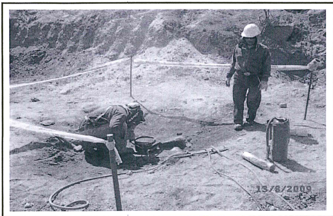
Foto 9. Cortando forro para soldar plancha que tapa el pozo.
