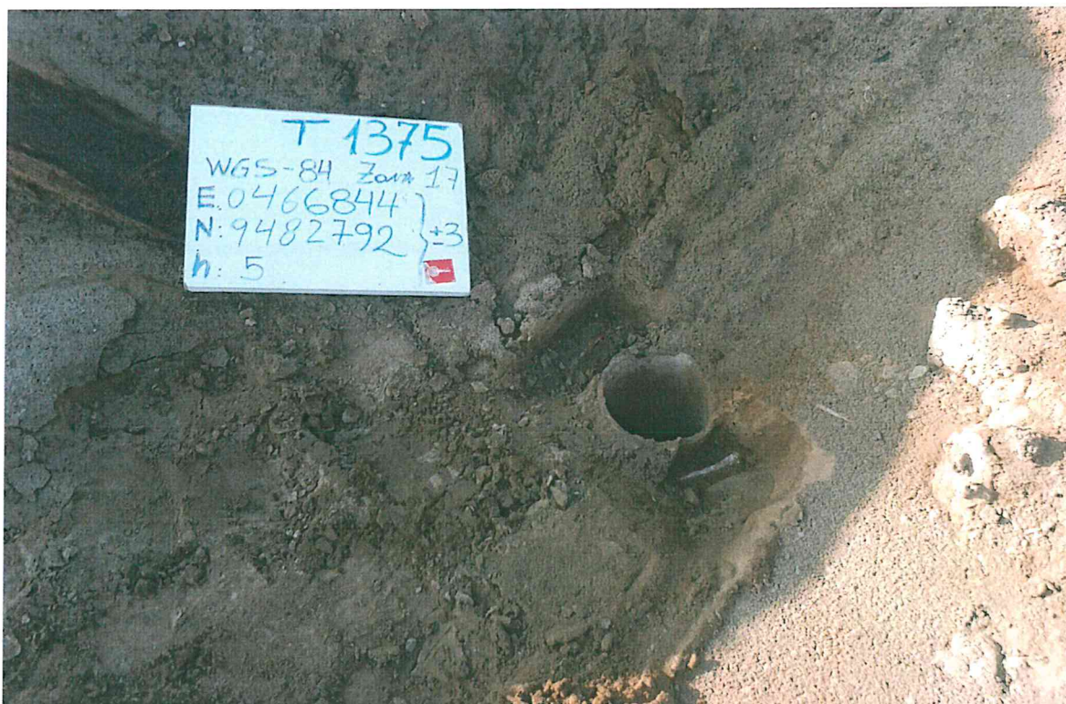
Fotografía N° 1. Vista del pozo mal abandonado donde se observó el casing enterrado y el tubing en la superficie.
