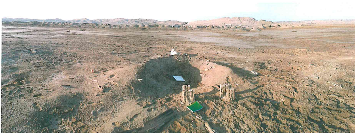
Fotografía N° 3. Vista panorámica del pozo mal abandonado, donde se observó ausencia de vegetación en los alrededores del área circundante del pozo.
