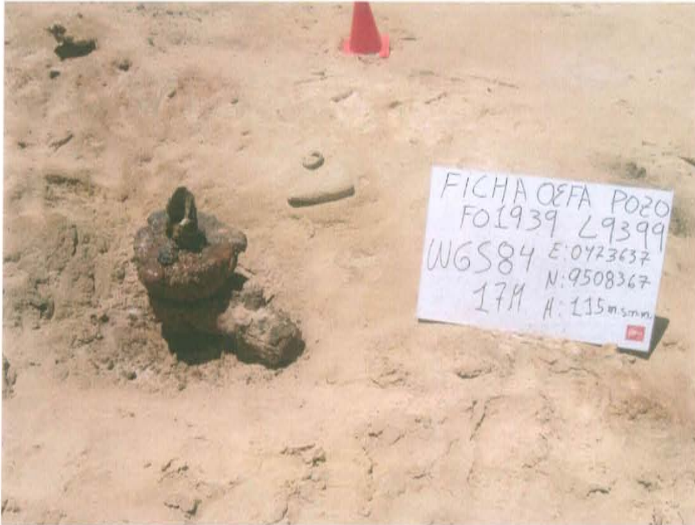
Fotografía N° 1. Identificación del pozo inactivo con código PERUPETRO L9399. Presenta casing abierta al medio ambiente.
