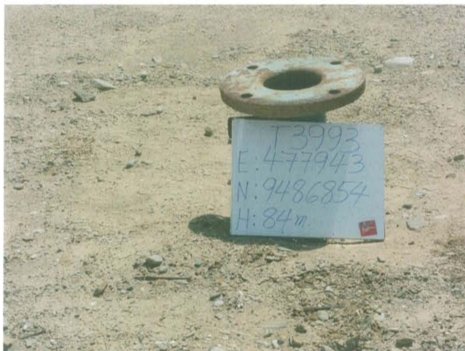
Fotografía N° 1. Pozo inactivo con código PERUPETRO T3993, en terreno habilitado tipo terraplén con acceso vial. El pozo está compuesto por una brida de 6 pulgadas de diámetro unida a un casing, dicho pozo sobresale 0,42 m sobre el nivel del suelo.
