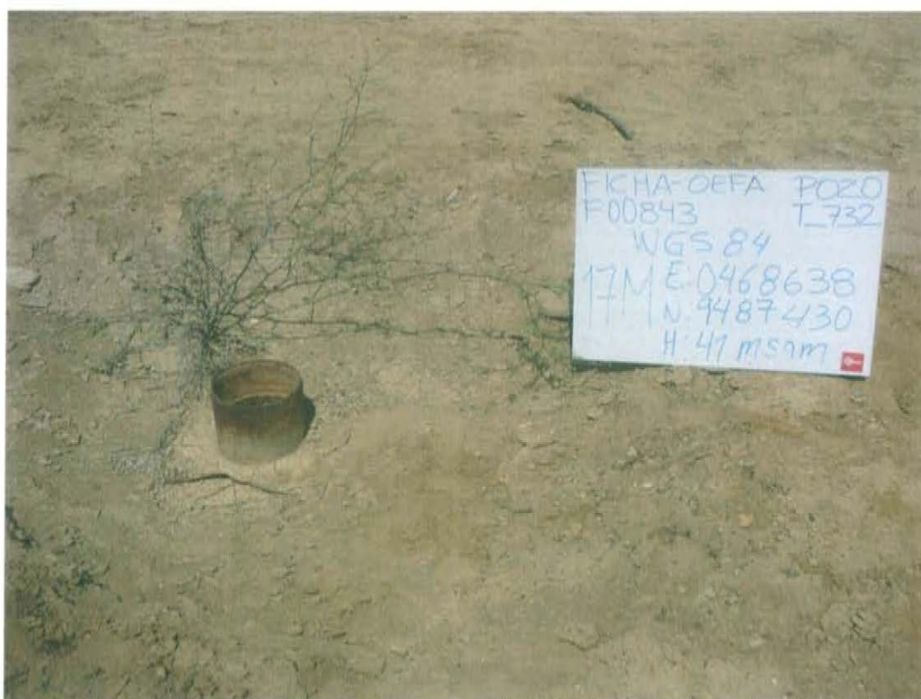
Fotografía N° 1. Pozo inactivo en terreno no habilitado sin acceso vehicular directo, se observó casing de 5 pulgadas de diámetro que sobresale 0,19 m sobre nivel del suelo.
