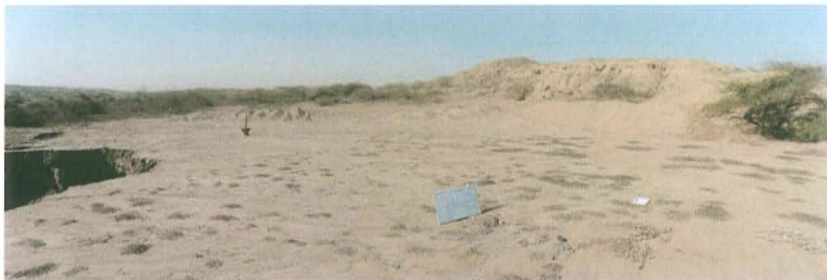
Fotografía N° 3. Vista panorámica de las inmediaciones al pozo, se observa el avance de la carcava por escorrentía superficial cuando se reactiva la quebrada.
