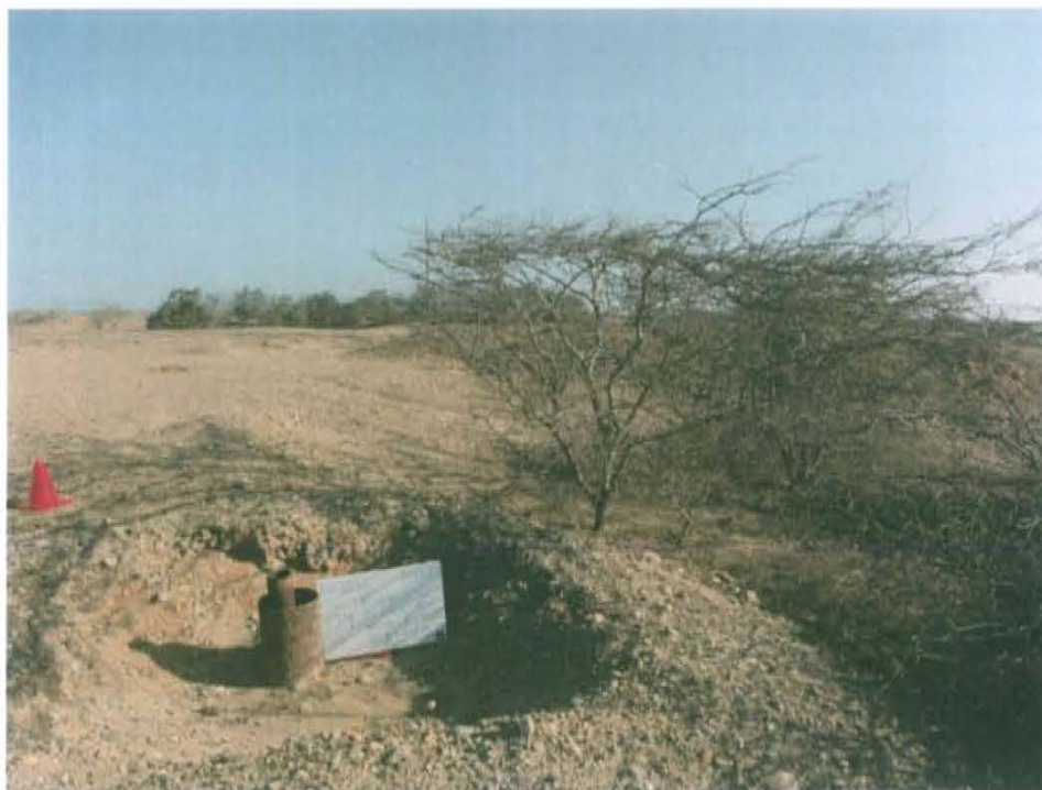
Fotografía N° 1. Vista panorámica donde se ubica el pozo en el interior de un hoyo de 2,3 \text{ m}^2 \times 0,3 \text{ m} de profundidad.
