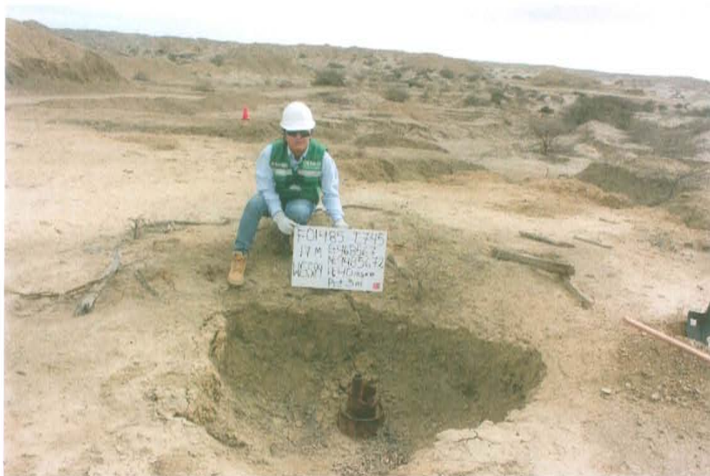
Fotografía N° 1. Vista del Pozo T_745, presenta casing de superficie y casing intermedio corroído y abierto.
