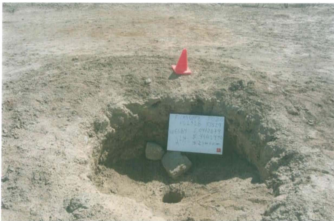
Fotografía N° 1. Pozo con código PERUPETRO T3529 y código Ficha OEFA F01918, se observa el casing dentro de un hoyo sin cabezal o algún elemento de cierre por lo que se encuentra abierto al ambiente.
