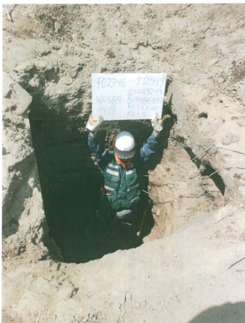
Fotografía N° 2. El pozo se encontraría enterrado en el interior de un hoyo, el cual presenta revestimiento de madera.
