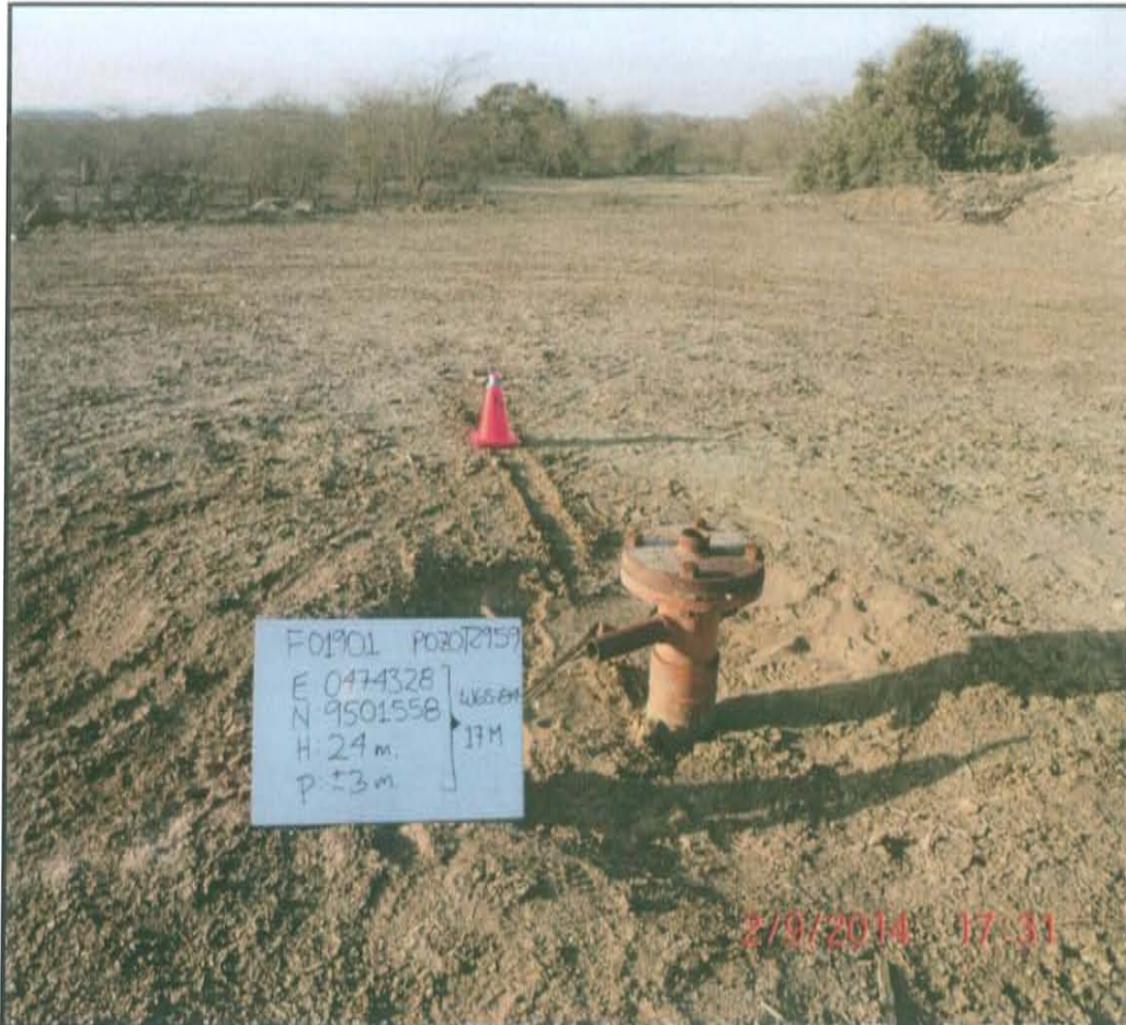
Fotografía N° 1. Pozo T2959 compuesto por casing de 6 plg de diámetro con brida de 16 plg en la parte superior que emerge 0,5 m desde la superficie del suelo.
