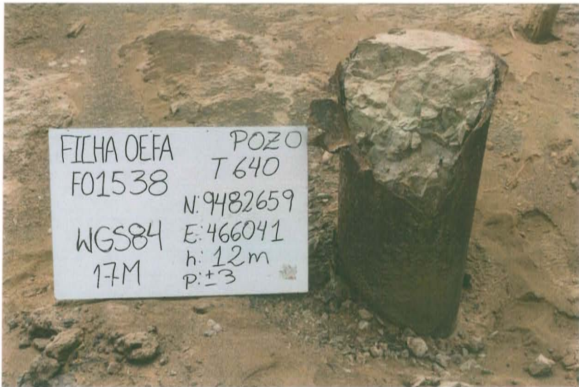
Fotografía N° 1. Identificación del pozo inactivo con código PERUPETRO T 640. Presenta casing corroído y con concreto visualizado solo a nivel superficial.
