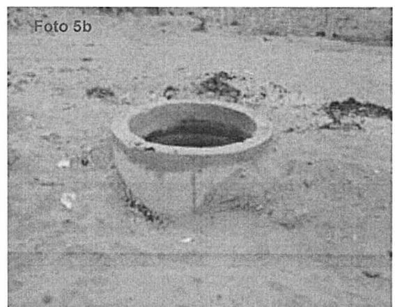
Fotografías N° 5a y 5b. Evidencias del tipo de infraestructura de los buzones artesanales de recuperación de aceites, en el punto georeferenciado N° 2, del cuadro N° 1. Coordenadas UTM WGS 84 (17L 767683E 8992396N)
