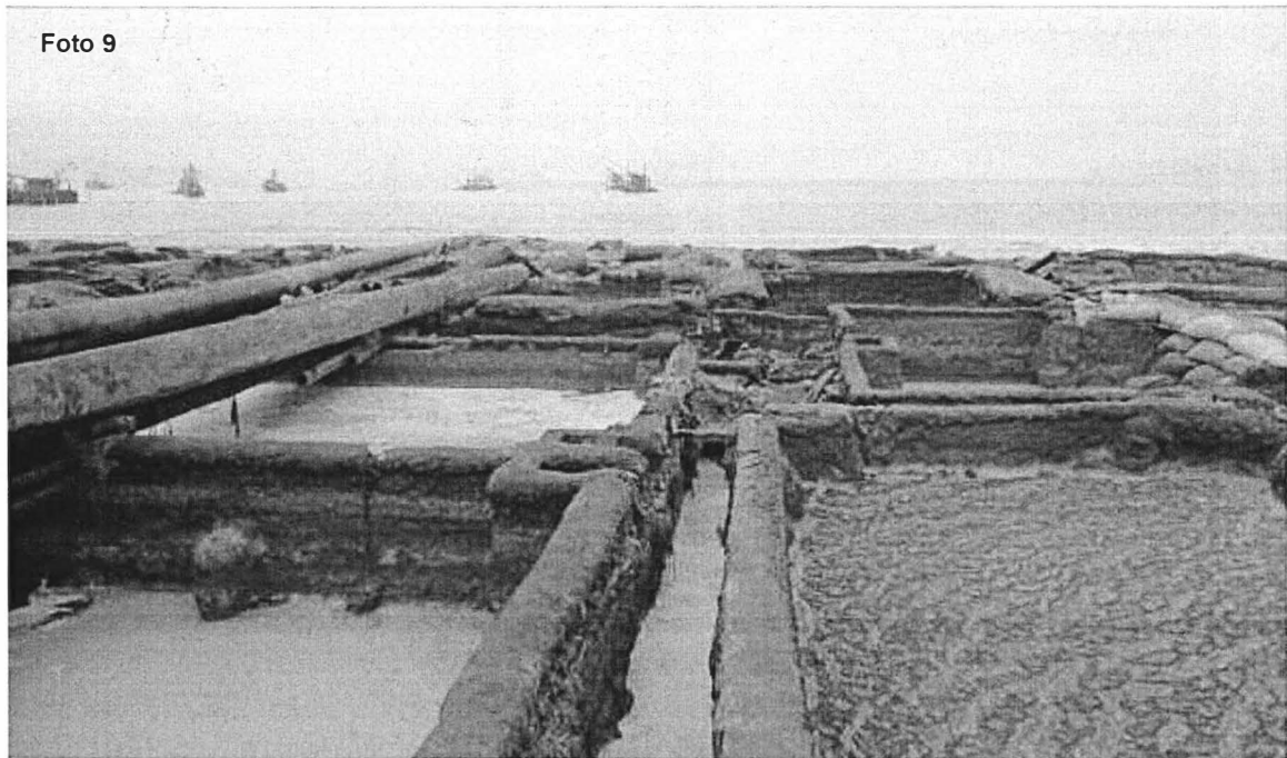
Fotografía N° 9. Evidencia de la operatividad de las pozas de recuperación informal de aceites, en el punto georeferenciado N° 3, del cuadro N° 1. Coordenadas UTM WGS 84 (17L 767547E 8992350N)
