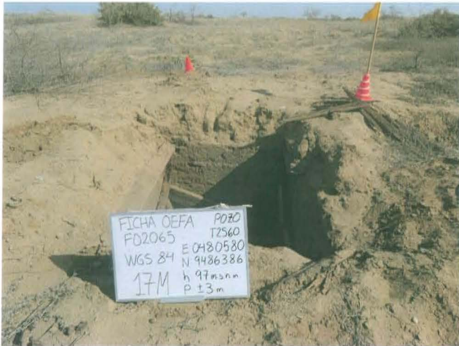
Fotografía N° 1. Se observa la ubicación del pozo inactivo, que presenta cantina deteriorada.
