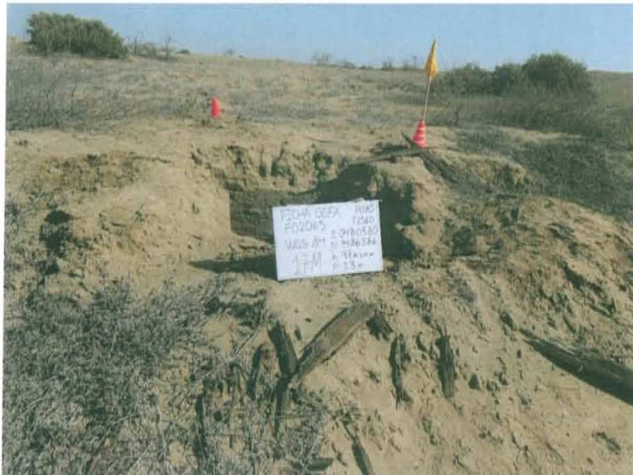
Fotografía N° 2. Se aprecia la cantina deteriorada; sin embargo no se visualizó el casing a nivel de superficie de la base de la cantina en mención.
