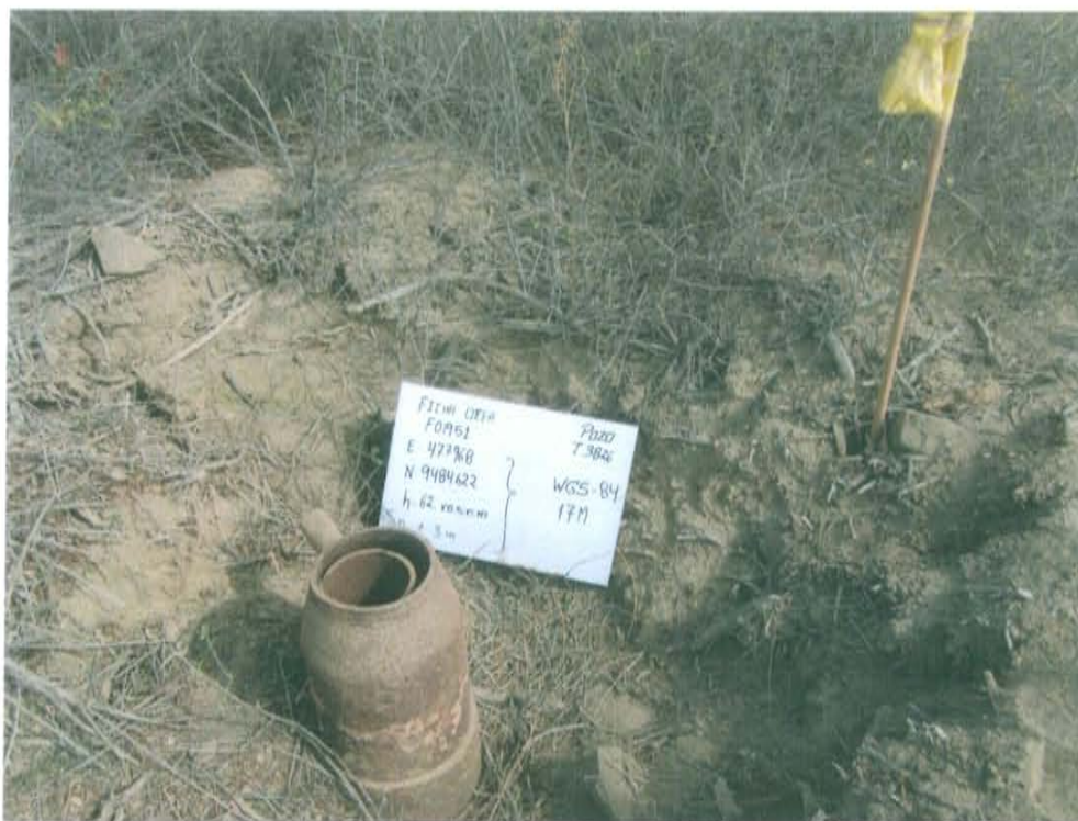
Fotografía N° 1. Se observa el Pozo T3826 con doble casing de 6,5 y 8,5 pulgadas aproximadamente se encuentra abierto y expuesto al ambiente
