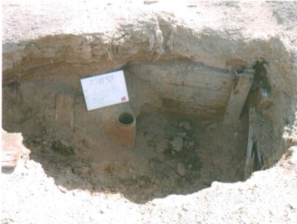
Fotografía N° 1. Vista del Pozo T 3839, presenta casing que sobresale 0,42 m sobre el nivel del suelo.
