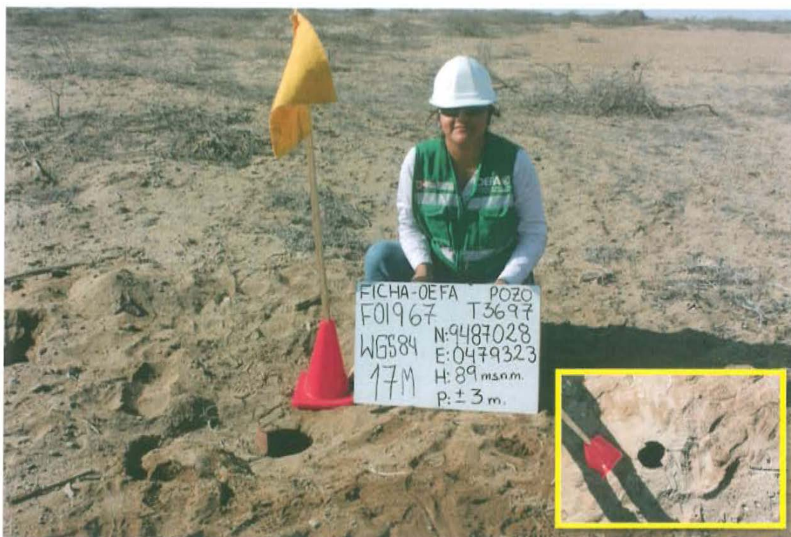
Fotografía N° 1. Pozo inactivo con código PERUPETRO T3697 donde se observa el casing a nivel de la superficie del suelo
