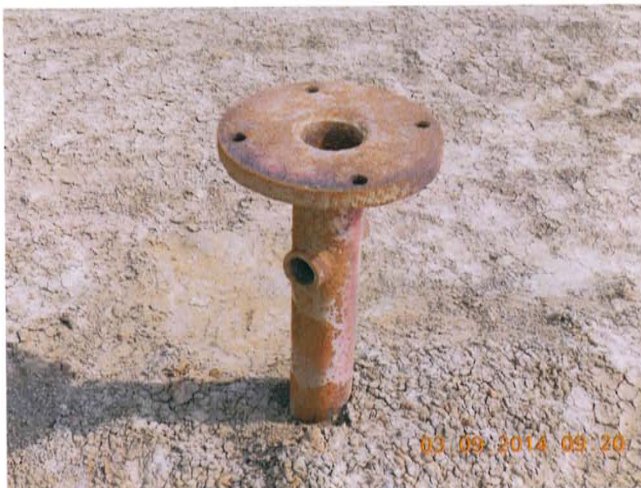
Fotografía N° 1. Pozo inactivo, con casing unido a la parte inferior correspondiente a la brida adaptadora, que se encuentra abierta sin elemento de cierre.
