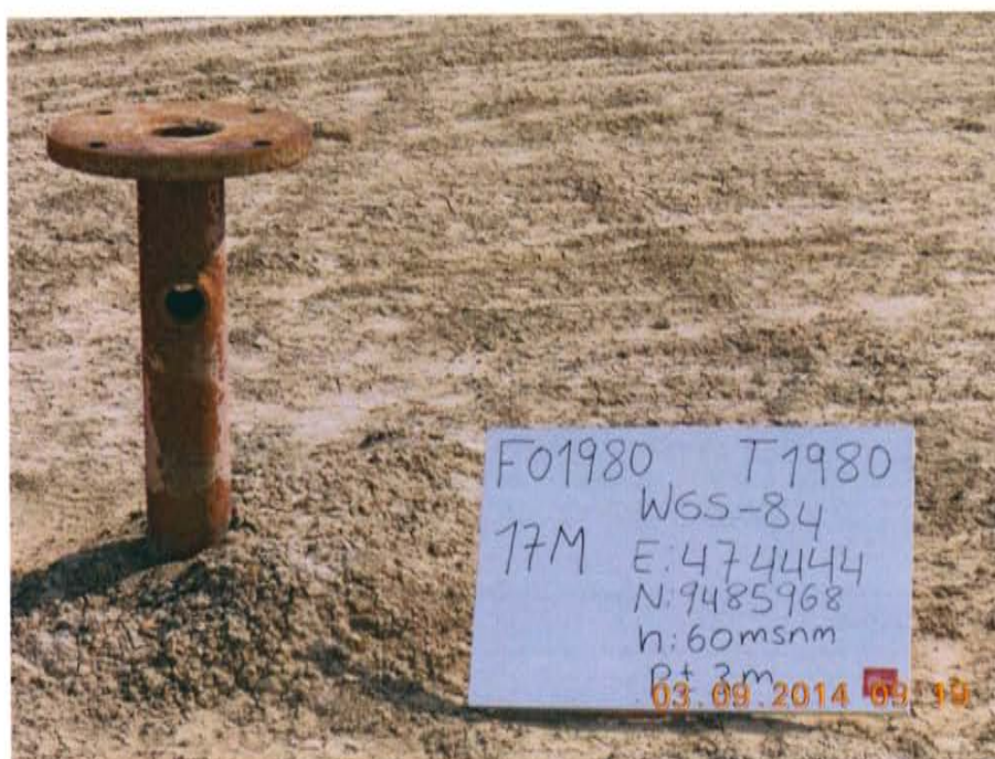
Fotografía N° 2. Se aprecia los orificios laterales y en la parte superior de la estructura del pozo, que no garantizan que se encuentre herméticamente cerrado.
