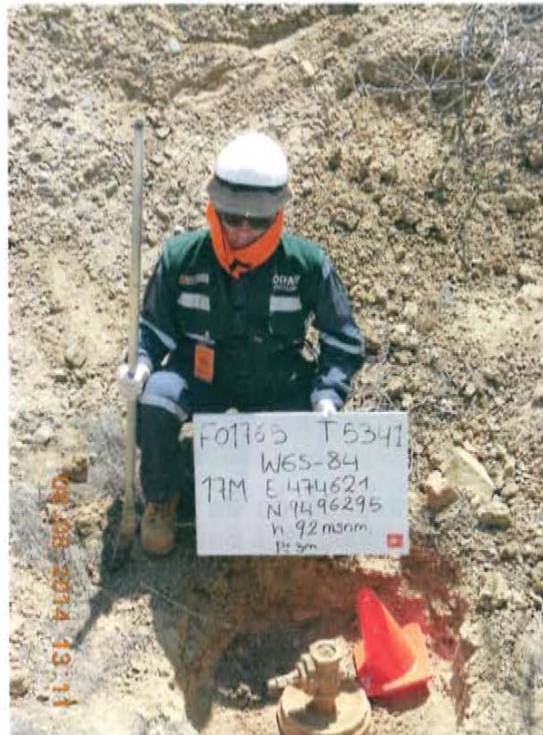
Fotografía N° 3. Coordenadas de ubicación del pozo T5341, donde se halló casing con cabezal y válvula de cierre.
