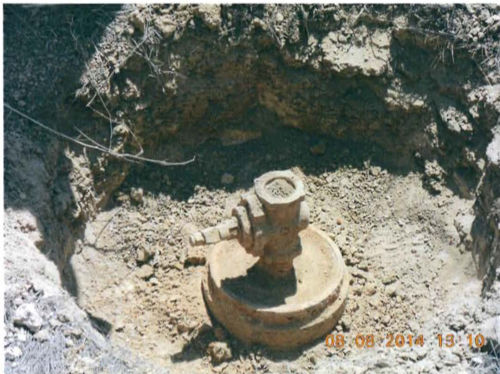
Fotografía N° 4. Se visualiza cabezal de 10 plg de diámetro con válvula sin volante, ubicado dentro de un hoyo de 0,3 m de profundidad.
