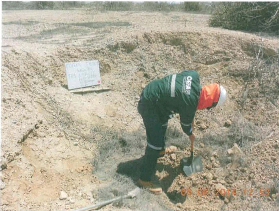
Fotografía N° 2. Se excavó 0,3 m de profundidad x 10 pulg de diámetro en el interior de un hoyo de mayor diámetro (24,5 m 2 x 2 m de profundidad) para encontrar el pozo.
