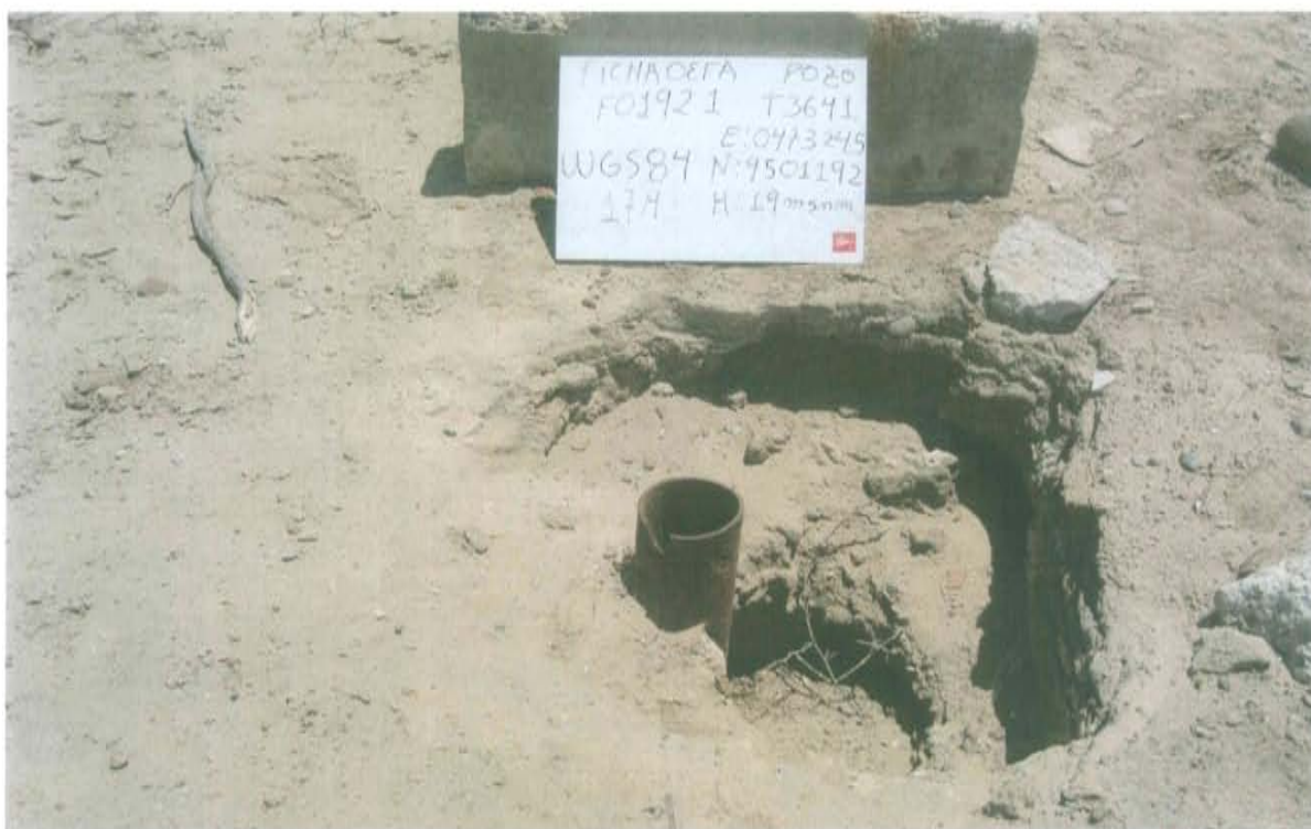
Fotografía N° 1. Pozo con código PERUPETRO T3641 y código Ficha OEFA F01921, se observa el casing corroído dentro de un hoyo sin cabezal o algún elemento de cierre por lo que se encuentra abierto al ambiente.
